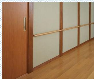
真壁など壁と柱の段差がある場合でも手すりを連続させられます。
