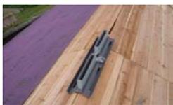
写真の下が棟に付くハットヘルスの架台です。換気面度からの空気を抜くあなです。この上にハットヘルス本体をつけます換気の仕組みですが夏場は屋根の裏はかなりの高温になります。瓦が熱され熱が屋根裏にこもります。暑い熱は上昇するのでこの換気により熱を外へ逃がします。
