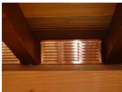
**換気面度・ハットヘルス**…上の写真が換気面度です。面度は垂木の間に入るものですが普通は木で取り付け換気が出来ないようになっています。この換気面度はいくつもの穴があいて風が通るようになっています。銅板でできていてこの穴から棟に向かって換気します。
